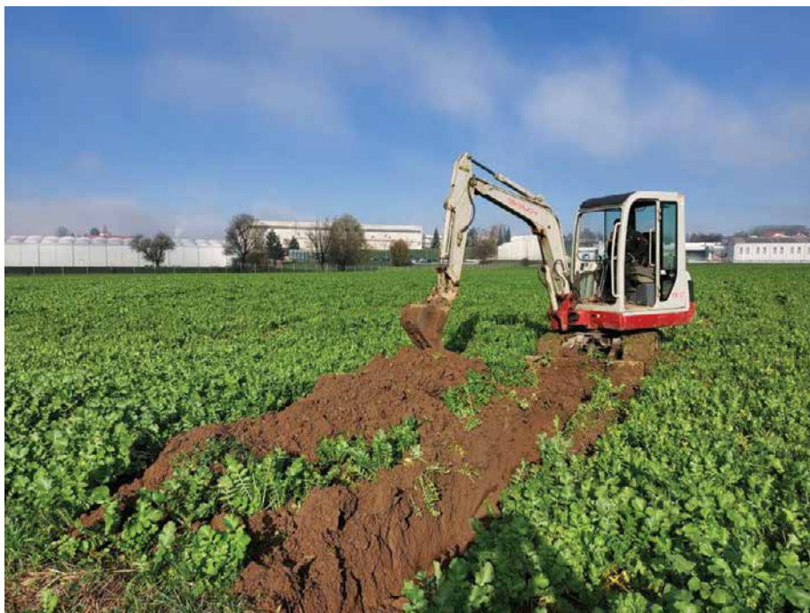
Slika: Izkop lizimetske jame
